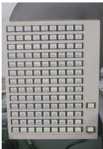
押しボタンを押すだけで、監視をおこないたい駅と、出力先のモニターを選択できる操作器(高島平運輸司令所)
