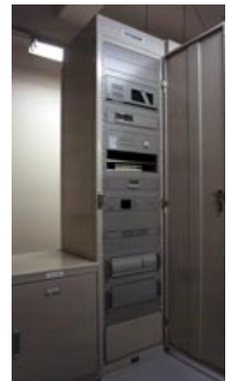
黒川運転指令室の信号変換記録装置
