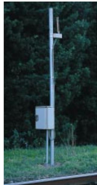
ホームの車両受信点から200m以内、高さ3.5mに設置されている送信アンテナ（上）とSS画像無線送受信機（下）
