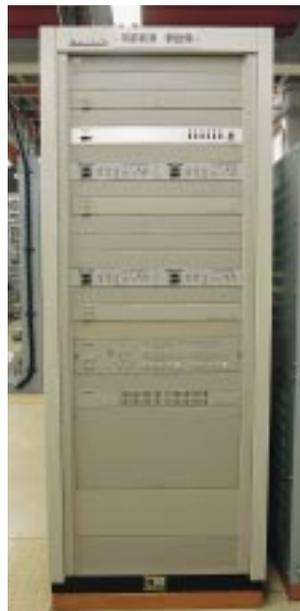
2台のカメラ映像を一画面に合成して送出するための映像制御装置架（各駅に設置）
