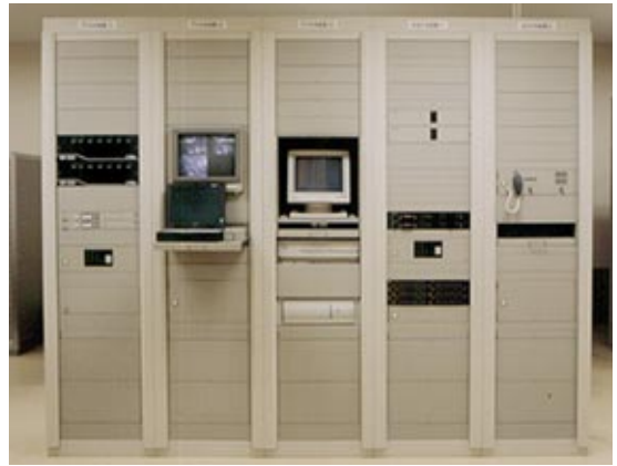
左からITV中央装置1～3と放送中央装置1・2
