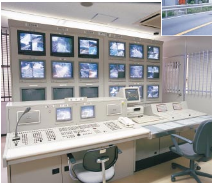
57台のカメラ映像は4分割表示とシーケンスモードで全て確認できます
